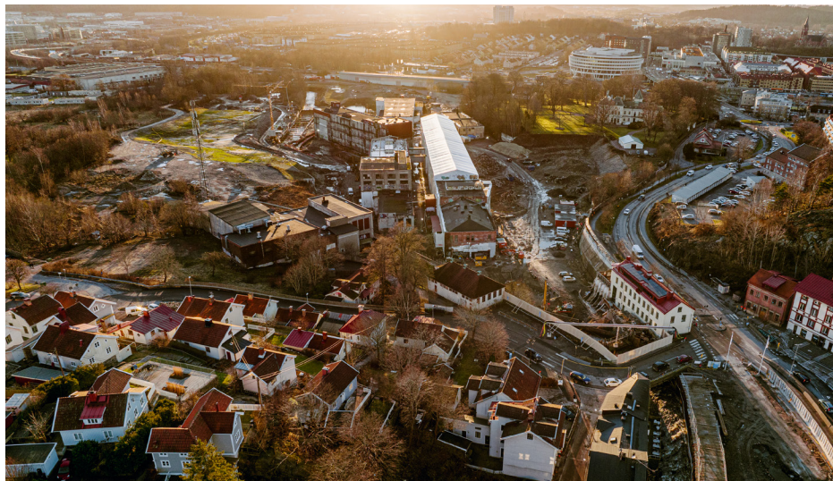
Flygfoto över Forsåkerområdet från februari 2022.
