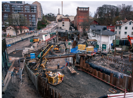
Vy över arbetsplatsen för det nya vattenintaget. På bilden är bron redan riven.
