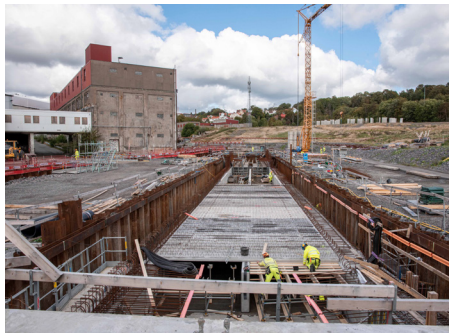
Bild över gjutningen av vattenspegeln, tagen från den nya Diagonalbron.
