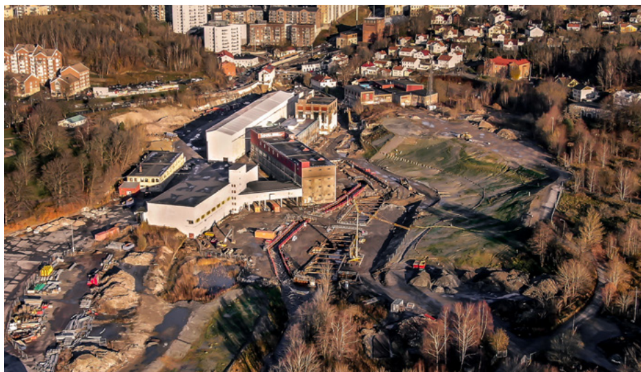
Flygfoto över Forsåkerområdet med vy över den framtida Vattenplatsen som just nu grävs ut. En temporär ränna har upprättats för att leda om vattnet så att grävning kan utföras i torrhet.
